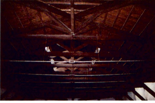
Istabl-ı Âmire-i Ferhan'da maneje binası, R. D'Aronco, çatı makaslarından bir görünüm.
